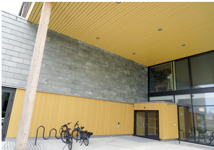
Hovedinngangen til det nye høyskolebygget i Haugesund sett fra vest.
