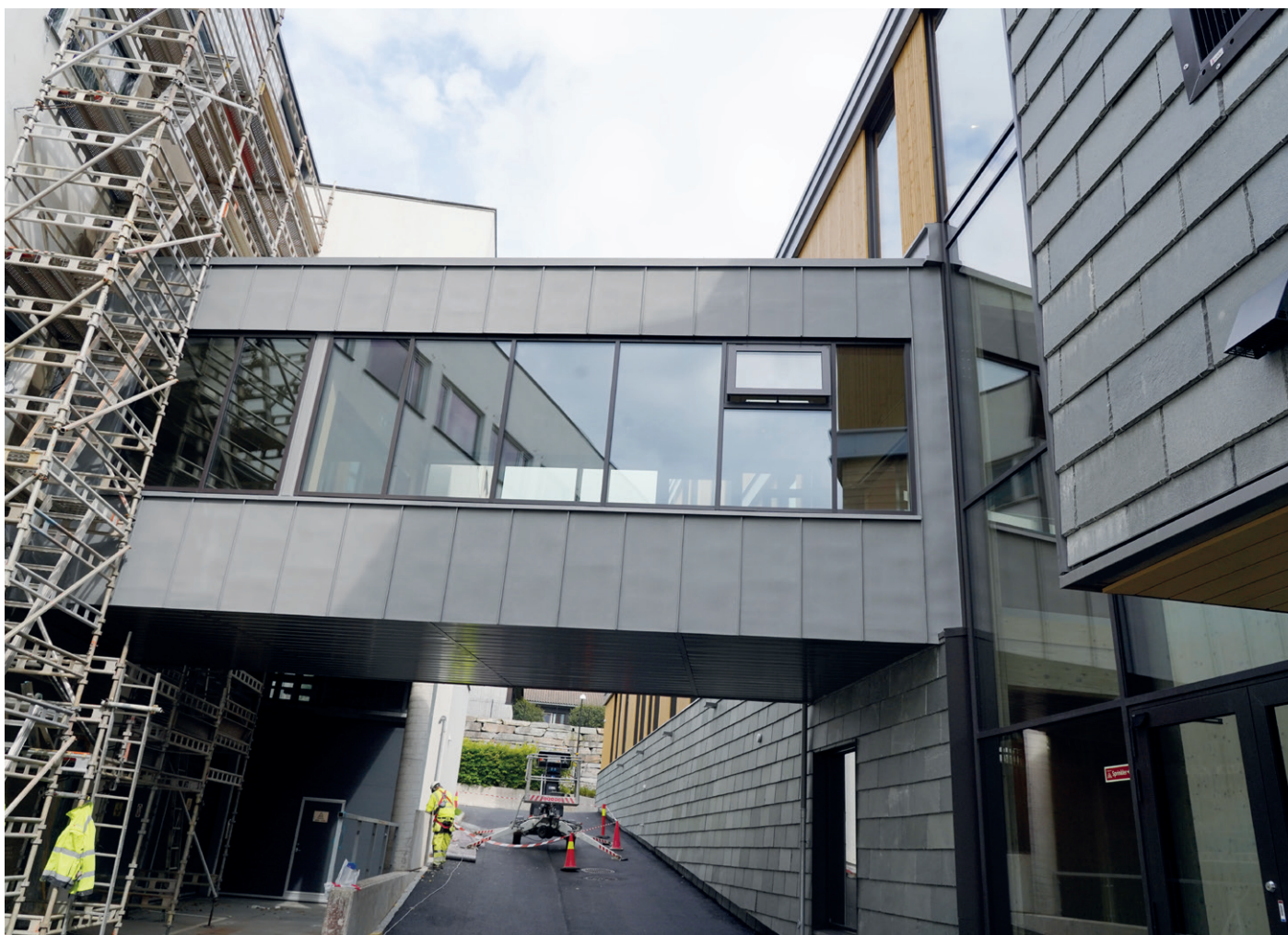
Det nye høyskolebygget er knyttet sammen med det «gamle» bygget gjennom ei overbygd gangbro.
